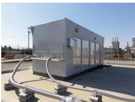
洗浄装置外観(送返油配管接続例)
